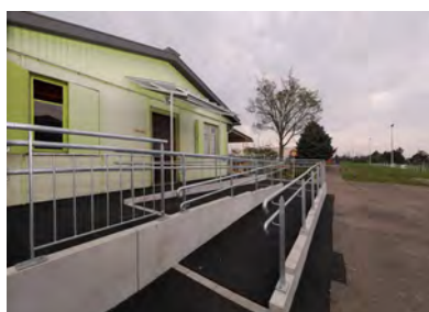
Stade de la Mittelharth
