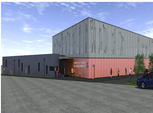
Grillenbreit : construction d'un gymnase
