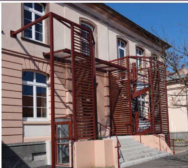
Travaux d'accessibilité à l'école Hirn
