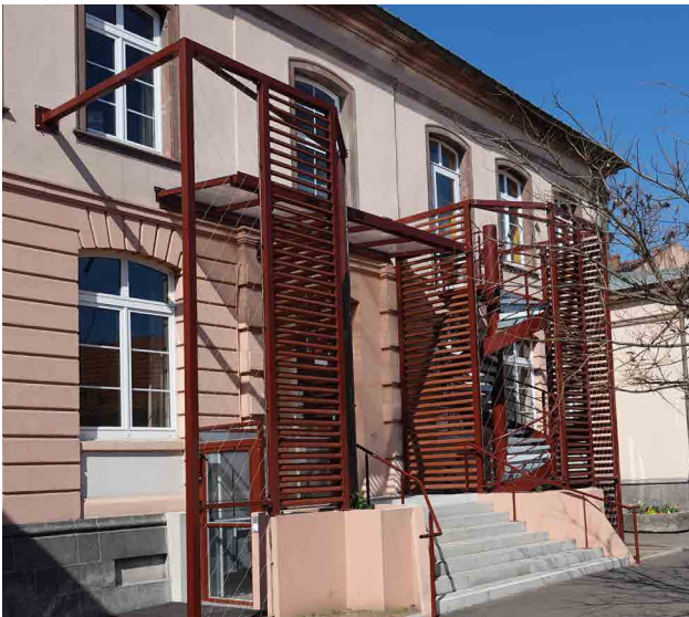
Travaux d'accessibilité à l'école Hirn
